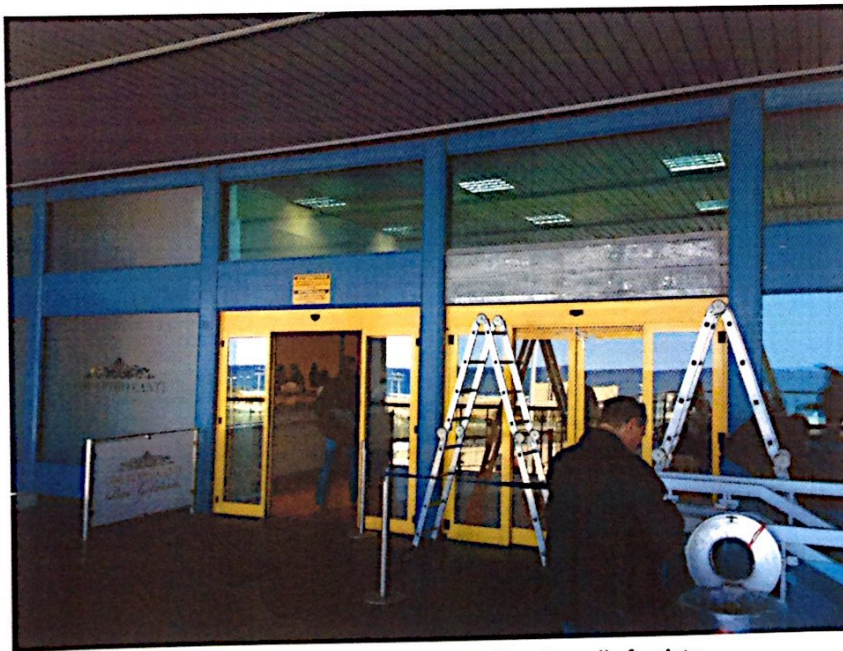
Lo stato attuale con le due porte inserite nella facciata
