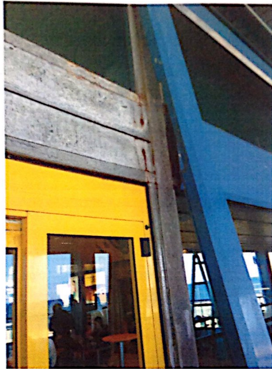
I telai delle porte inserite nella facciata
