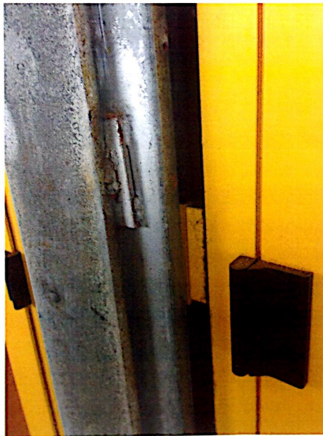
I telai delle porte inserite nella facciata
