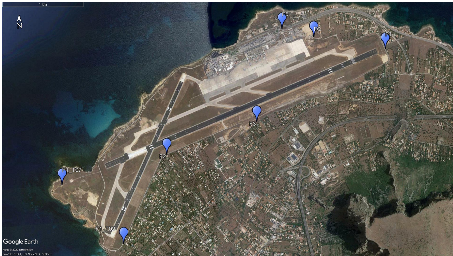
Figura 4. Inquadramento aerofotografico generale con postazione delle centraline per il monitoraggio delle emissioni rumorose – configurazione a regime
